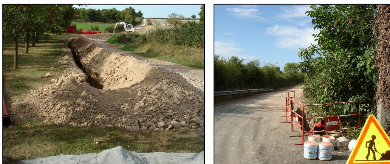
Un exemple de travaux pour le raccordement au réseau public de distribution (Source : VALOREM)
