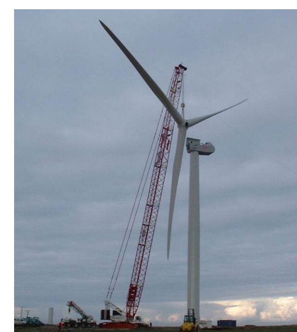
Le montage du rotor
