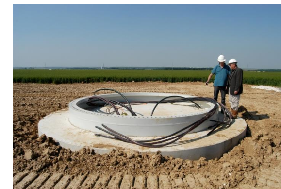
La fondation terminée
